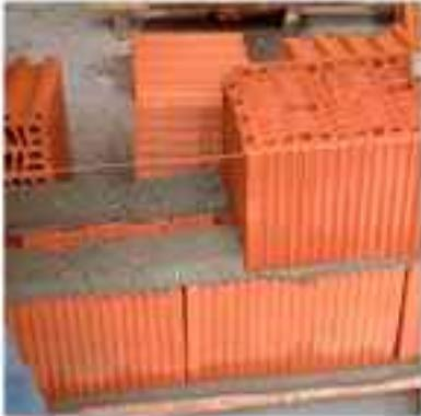
En muros exteriores de una sola hoja, el tendel se realizará con dos bandas de mortero separadas como máximo 2 cm.
