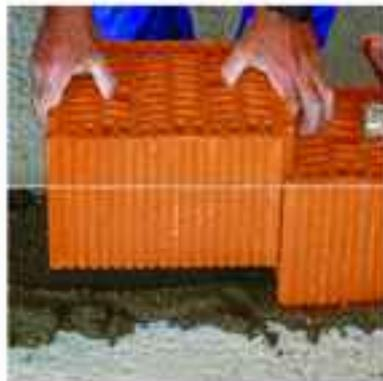
Colocar los bloques verticalmente, no a restregón, haciendo tope con los machiembrados.
