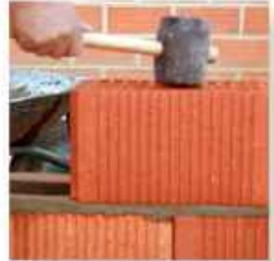
Cada 100 bloques colocados, retirar uno para comprobar la correcta ejecución de la junta horizontal:
