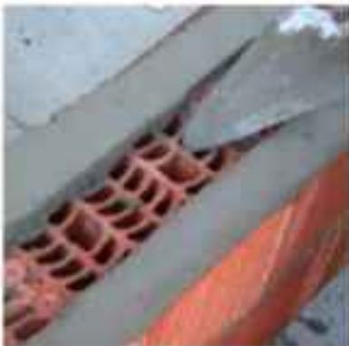
Es importante la colocación de un espesor suficiente de mortero, unos 3 cm.
